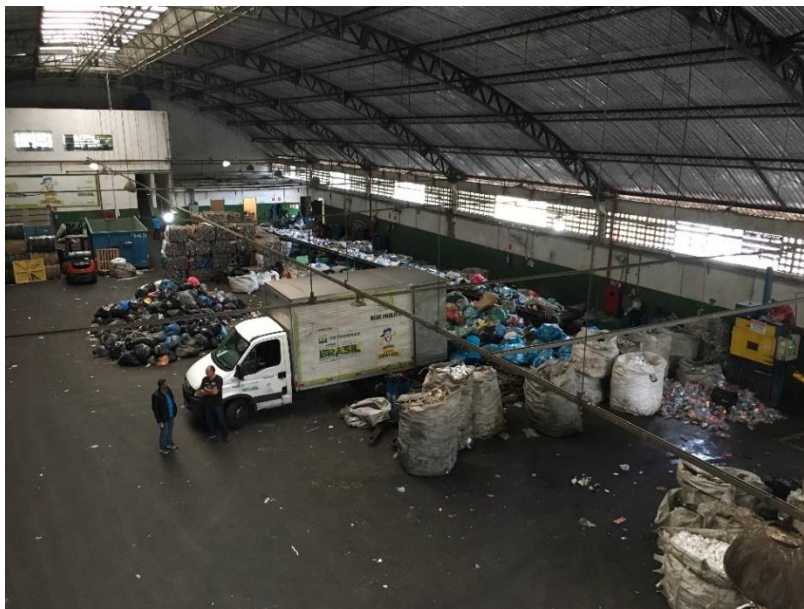
Figura 18 - Área de circulação e movimentação de carga, esteira de triagem e estoque de resíduos sólidos
